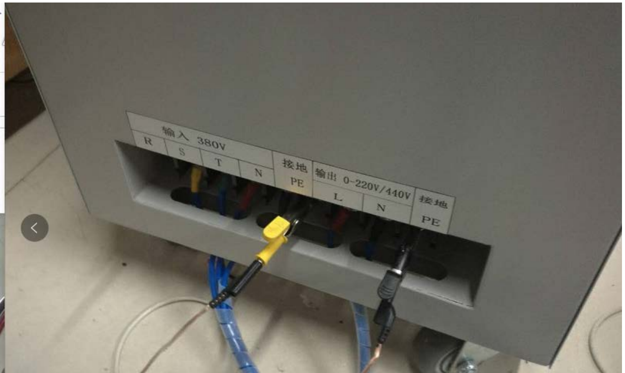
图 5 试验变压器参考接线
